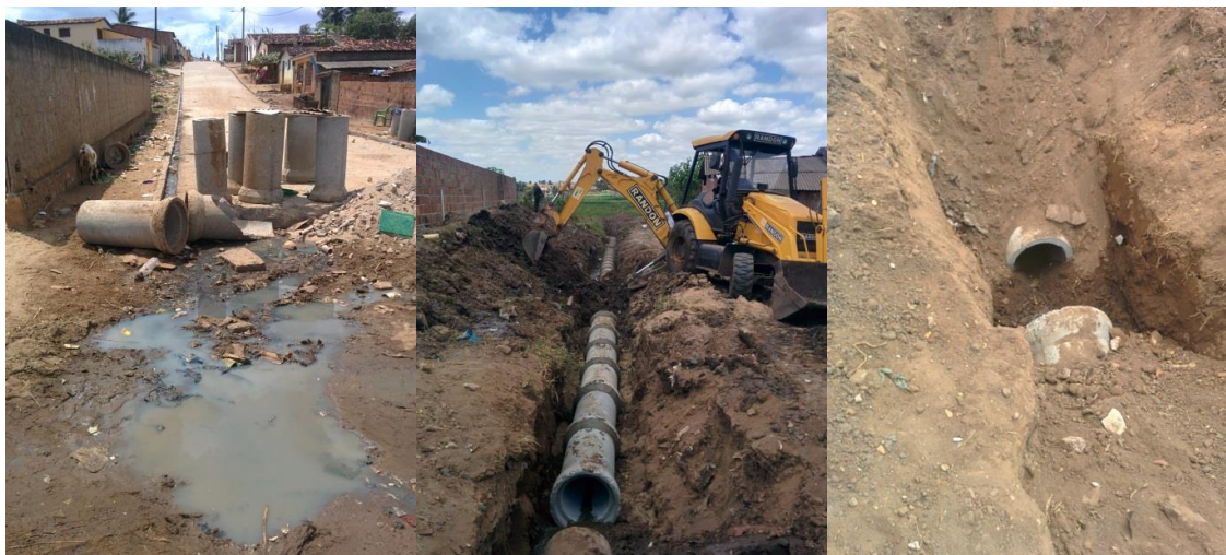
Figura 50. Serviços de ampliação da rede de drenagem.
