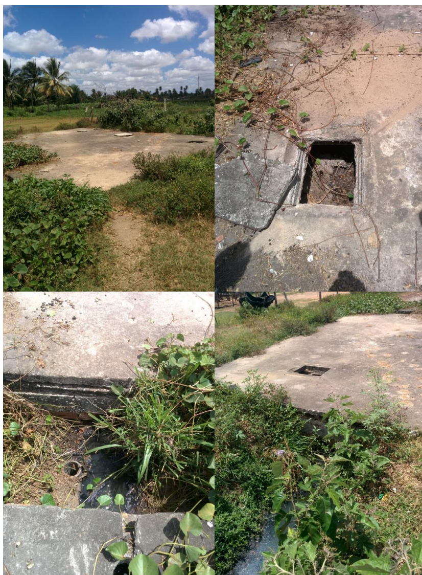
Figura 48. Sistema assoreado de fossas.
