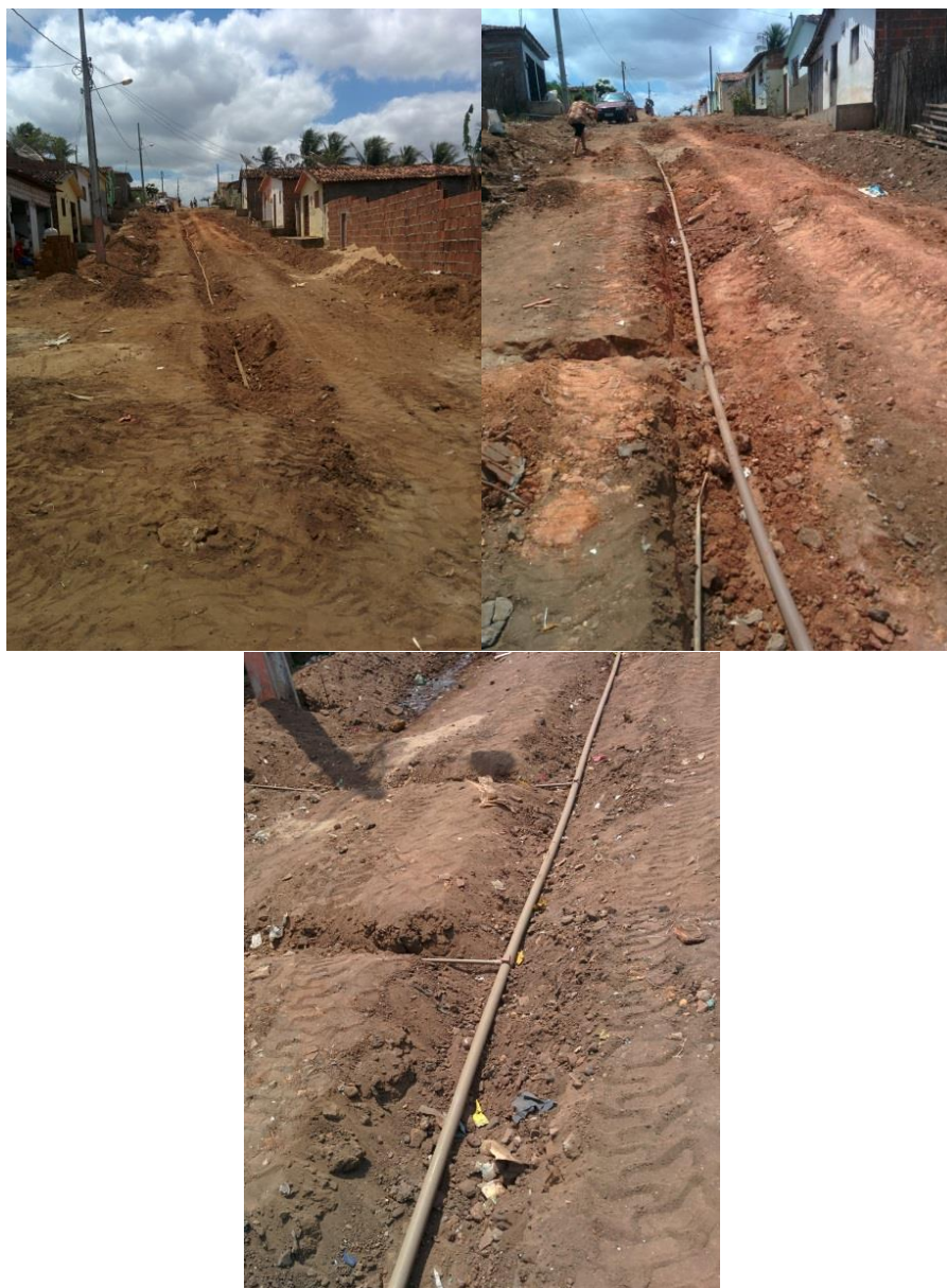
Figura 44. Instalação da rede de abastecimento de água em rua antes da pavimentação.
