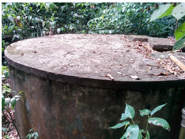
Figura 41. Ponto de captação na nascente.
