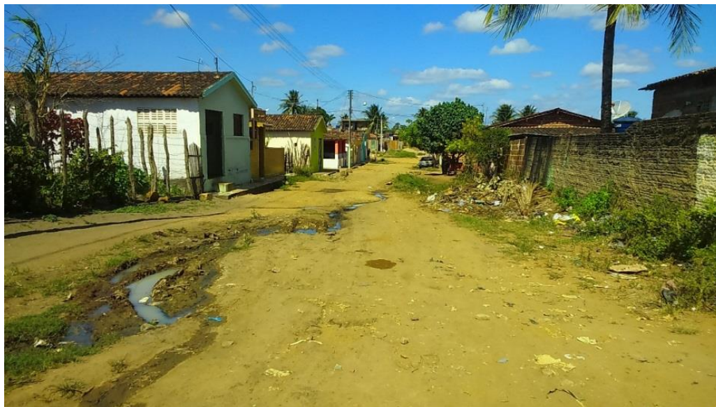
Figura 39. Esgoto a céu aberto em Itapororoca/PB.
