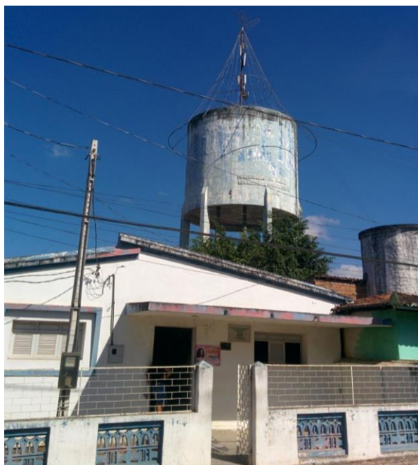
Figura 43. Reservatório de água tratada a ser distribuída em Itapororoca.
